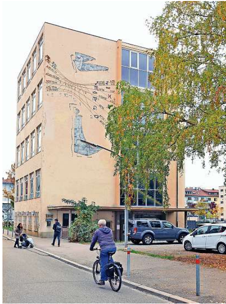
Im Treppenturm der ehemaligen Alfons-Kern-Schule wird derzeit nur das Erdgeschoss genutzt. Das könnte sich bald ändern.
