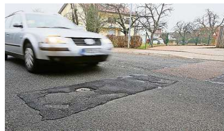
Gefährlich für Achsen und Stoßdämpfer sind Querrillen, wie hier in Hohenwart.
